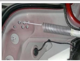
2.2 拆原车气弹簧 把原车左边气弹簧拆卸；拆气弹簧时需有人撑起尾门，防止掉下
